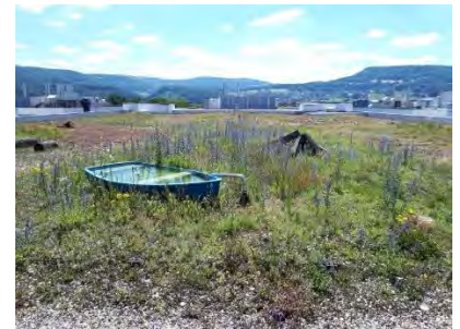
extensive Dachbegrünung des Parkhaus Kägen
