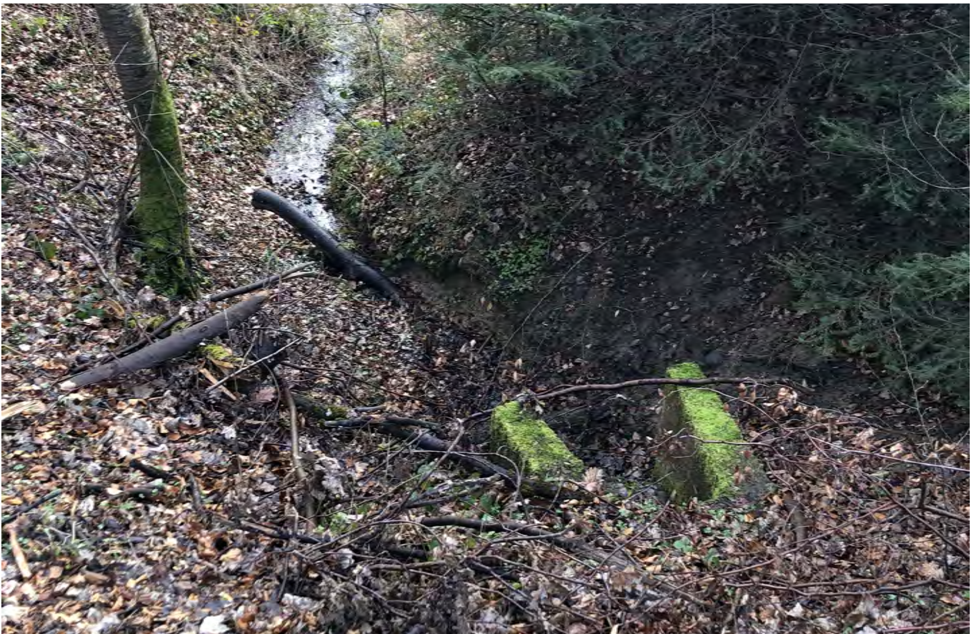
Foto 8: Blick bachabwärts vom Weg etwa 10m unterhalb der „Quelle“.
