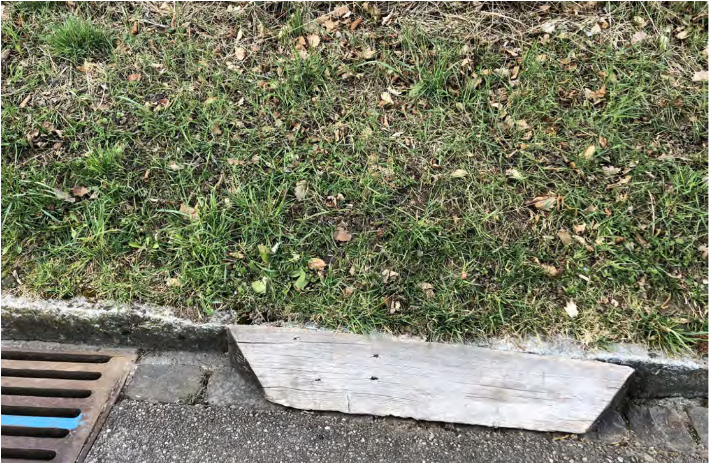
Foto 3: Wanderhilfe für Amphibien über Strassenstellriemen, in den Kanalisationsschächten sind Ausstiegshilfen integriert.
