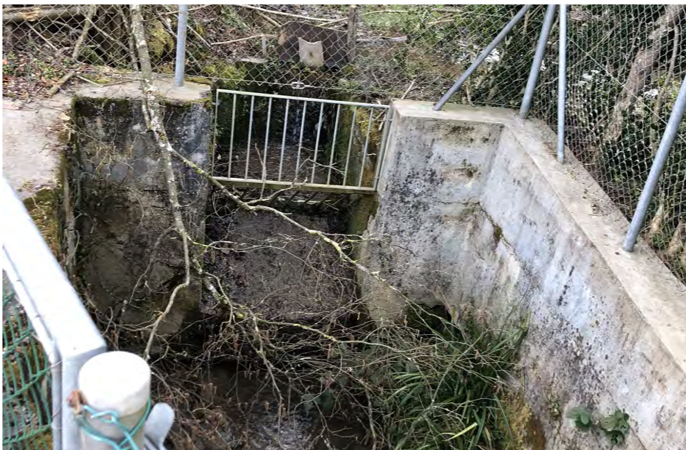
Foto 2: Fassung/Eindohlung Schönenbach auf Höhe Parzelle 1065.
